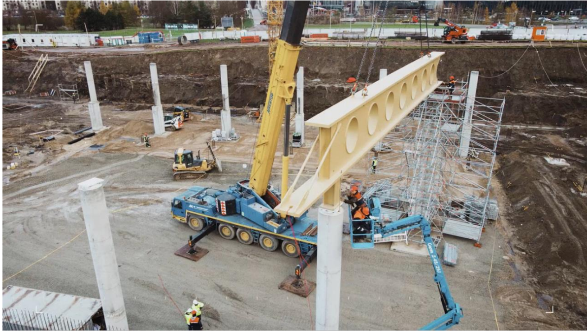
16 paveikslas. Konstrukcijų montavimas Objekte. Šaltinis: Conresta
